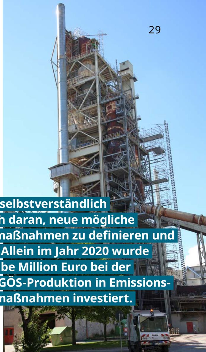
Der Wärmetauscherturm ist mit dem Drehrohröfen und dem Zentralen Leitstand das Herzstück der Zementproduktion
