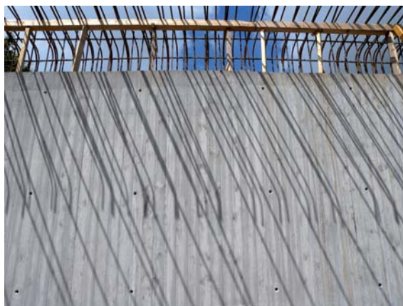
Brückenwiderlager mit Brettschalung
