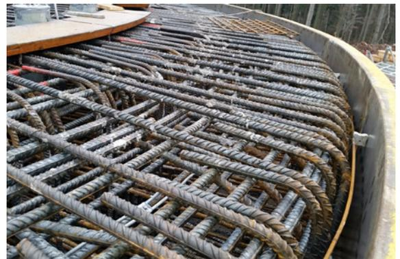
Bild 17: Fundament Windkraftanlage
