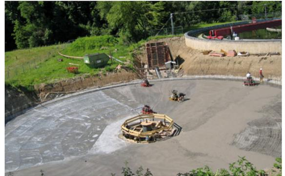
Bild 12: Bodenplatte Kläranlage
