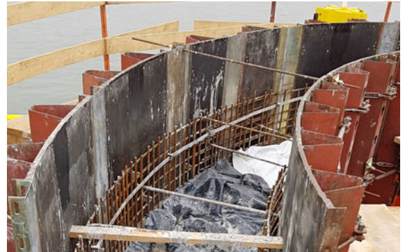
Bild 24: Wand Einlassbauwerk Rhein
