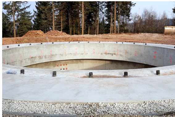
Bild 27: Fundament Windkraftanlage
