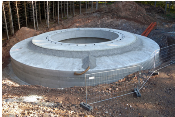
Bild 19: Fundament Windkraftanlage
