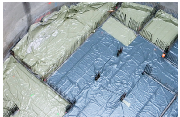
Bild 21: Nachbehandlung Bodenplatte
