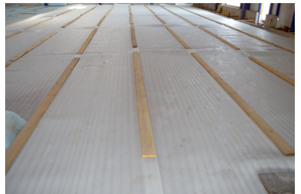
Bild 9: Nachbehandlung mit Thermomatten
