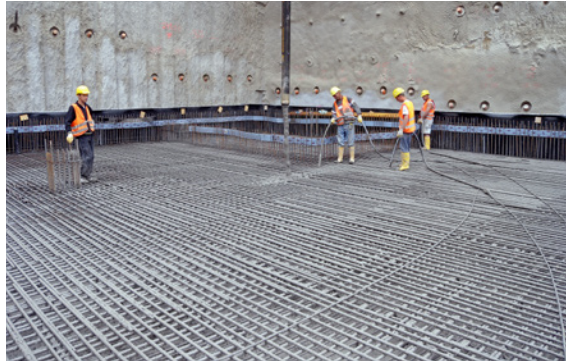
Bild 10: Betoneinbau Gerberareal
