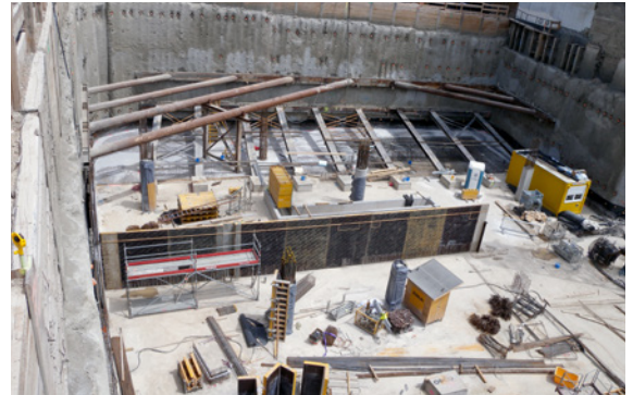
Bild 12: Bodenplatte Gerberareal
