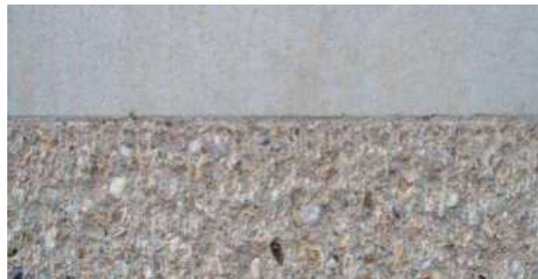
Abb. 8.3.20 Stocken einer Betonoberfläche
