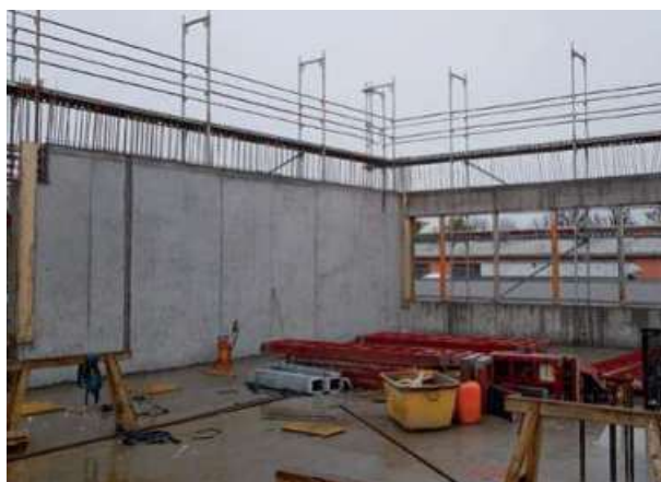
Abb. 1.4.5 Sichtbetonwände aus R-Beton mit Gesteinskörnung Typ 2
