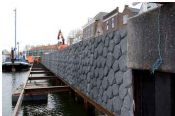
Abb. 9.6.3 (links) Betonblockmatten beim Verlegen
