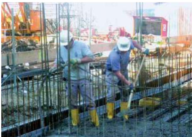
Abb. 5.1.6 Verdichten von Frischbeton
