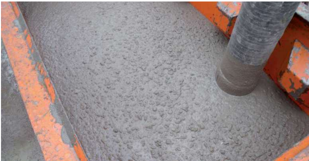
Abb. 8.12.7 Befüllung eines LEGO-Steins mit Unterwasserbeton
