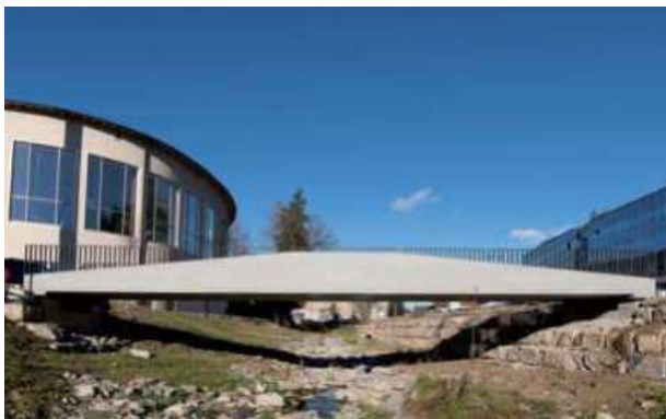
Abb. 9.5.5 Carbonbetonbrücke Albstadt-1, Bild: solidian GmbH
