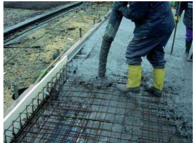
Abb. 7.4.6 Leichtverdichtbarer Beton F6
