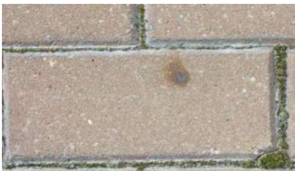
Abb. 10.2.16 Braunverfärbung durch Pyrit im Vorsatz eines Pflastersteins
