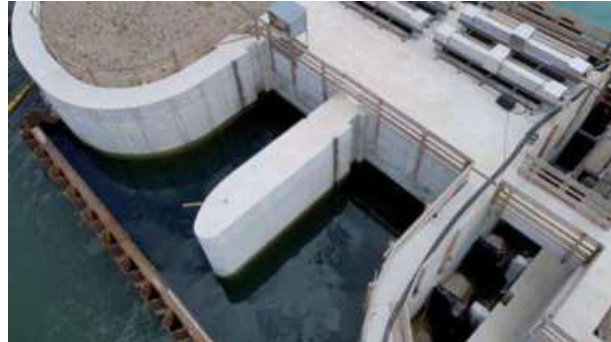
Abb. 8.2.2 (links) Hochwasser Einlassbauwerk - Überlauf bei Hochwasser auf dem Rhein
