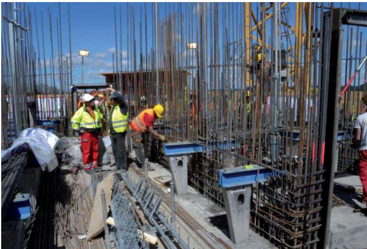
Abb. 0.0.2 Baustelle Gleitschalungsbau im Gleitmodus, Aufzugstestturm Rottweil
