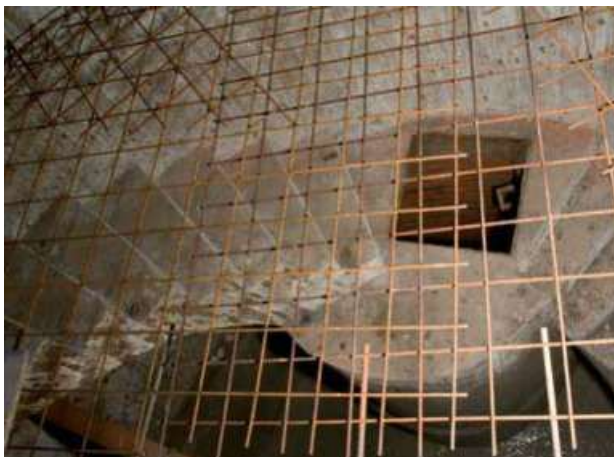
Abb. 8.17.8 (links) Hohlraumfreie Bauwerksverfüllung mit Treppen, Schächten und Rohrleitungen
