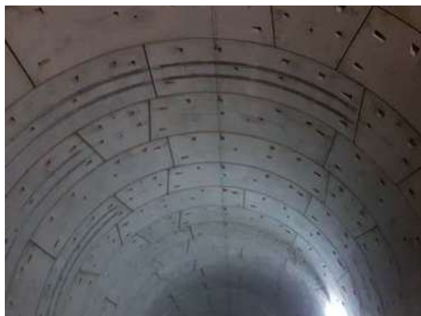
Abb. 8.7.5 Tübbinge im Gewölbe verbaut
