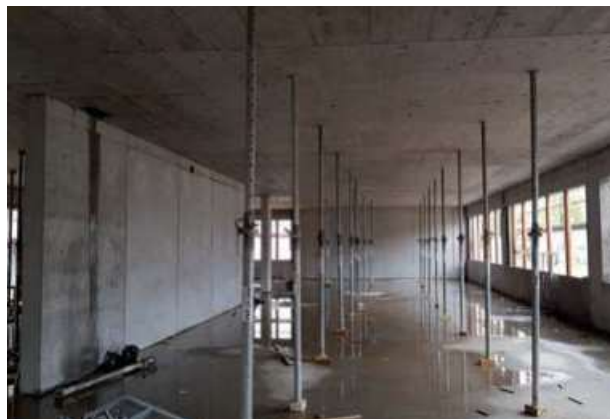
Abb. 7.15.4 Schulgebäude in Sichtbeton mit R-Beton
