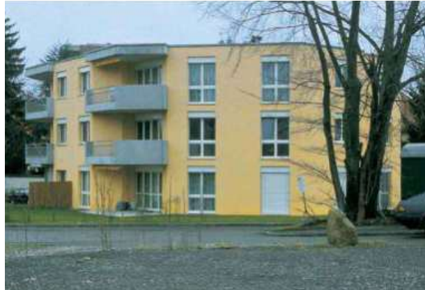
Abb. 7.15.3 Mehrfamilienhaus gebaut mit R-Beton
