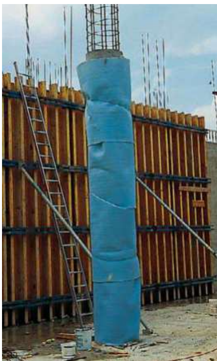
Abb. 5.2.2 Ummantelung einer Betonstütze mit Thermomatte
