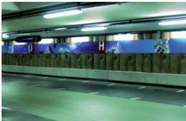
Abb. 8.4.1 (links) Stark befahrenes Parkhaus
