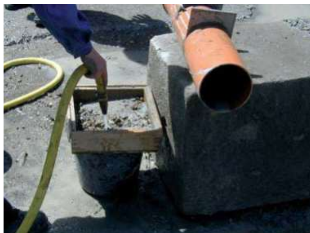
Abb. 10.1.4 (links) Entleeren eines Teils der Rohrfüllung
