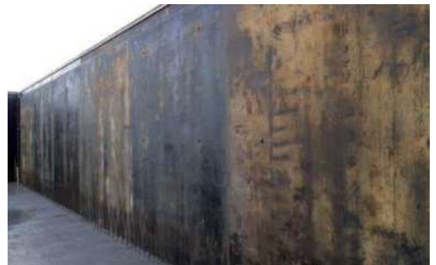
Abb. 10.2.12 Phenolharzbeschichtete Schalhaut
