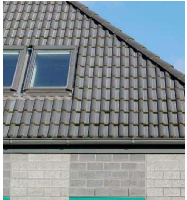
Abb. 9.3.2 Dachstuhl mit Betondachsteinen
