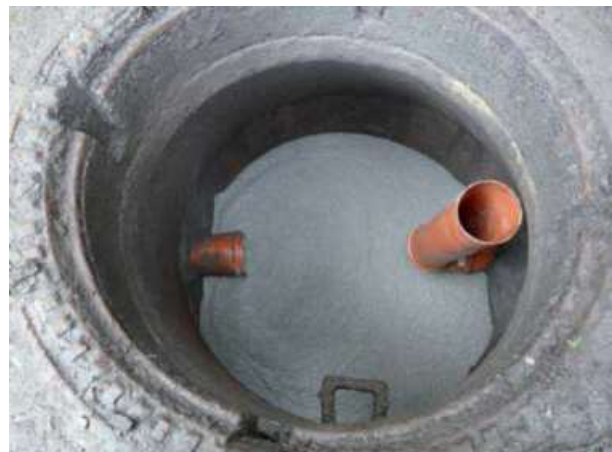
Abb. 8.17.5 Ringraumverfüllung nach Einzug einer neuen Rohrlei- tung in den alten Kanal
