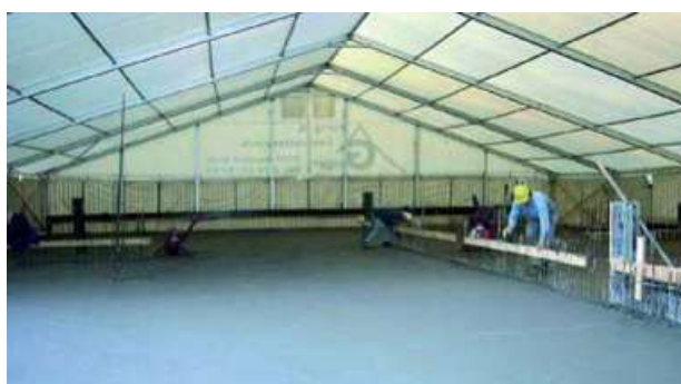
Abb. 5.2.10 Witterungsgeschütztes Arbeiten unter der Einhausung
