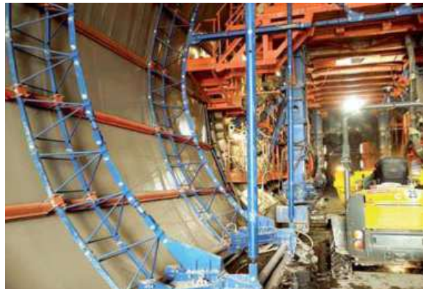
Abb. 8.7.4 Ringraumverfüllung
