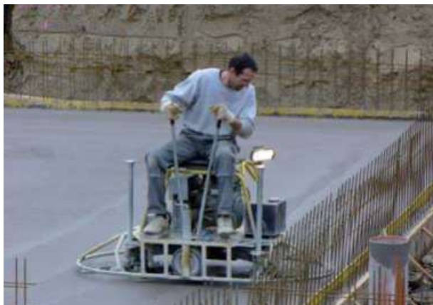
Abb. 8.14.1 Maschinelles Glätten einer Bodenplatte mit dem Flügelglätter - Doppelglätter
