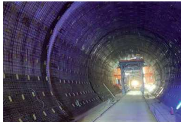
Abb. 8.7.2 Tunnelinnenschale
