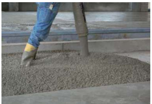
Abb. 8.16.3 Stahlfaserbeton – Frischbeton beim Einbau mit der Pumpe
