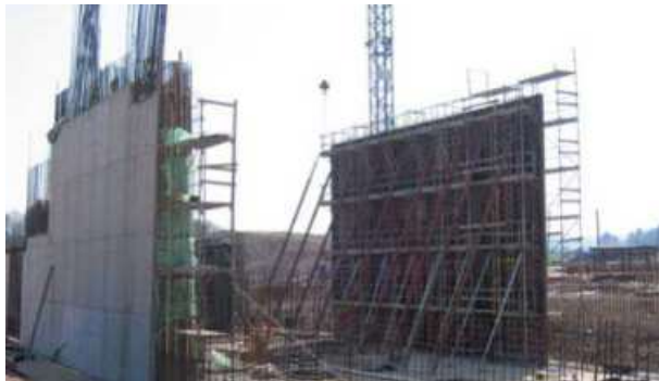
Abb. 8.5.1 Wasserbauwerk mit sehr starken Wänden
