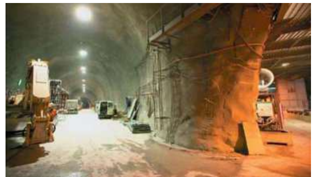
Abb. 7.10.8 Sicherung des Gebirges mit Spritzbeton
