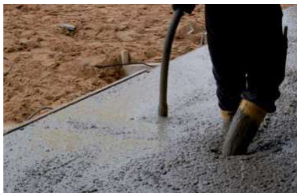
Abb. 7.8.11 Verdichten von Stahlfaserbeton
