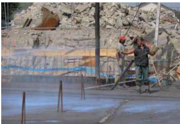
Abb. 8.14.6 Zwischennachbehandlung mit Curing
