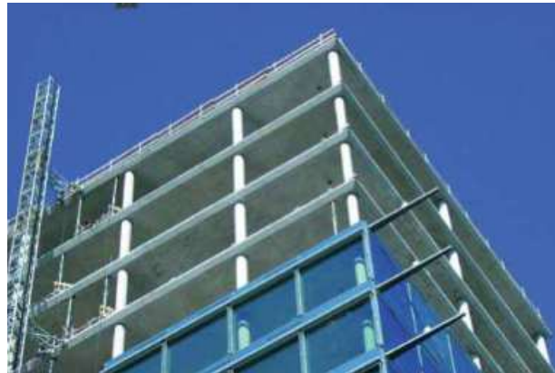
Abb. 1.6.5 Stark belastete Stütze aus Hochleistungsbeton mit Silikastaub
