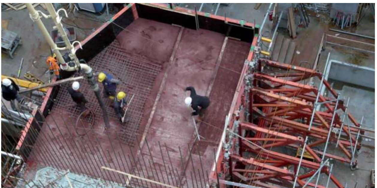
Abb. 7.7.1 DESY: Einbau Strahlenschutzbeton mit Hämatit, Trockenrohddichte 3.750 kg/m 3
