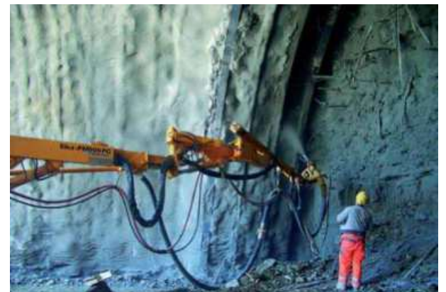
Abb. 7.10.8 Sicherung des Gebirges mit Spritzbeton
