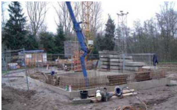
Abb. 8.12.1 (links) Betonage eines Unterwasserbauwerks
