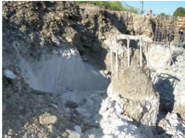
Abb. 10.6.3 Bohrpfähle mit SR-Zement im gipshaltigen Boden
