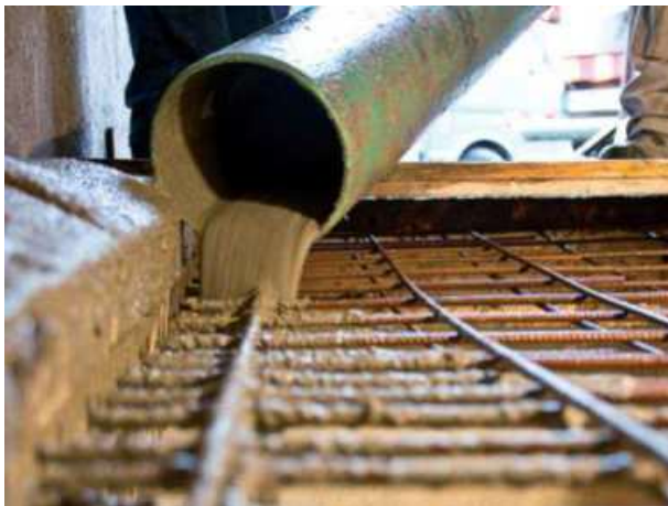
Abb. 8.17.7 Verfüllung über Rohrleitung
