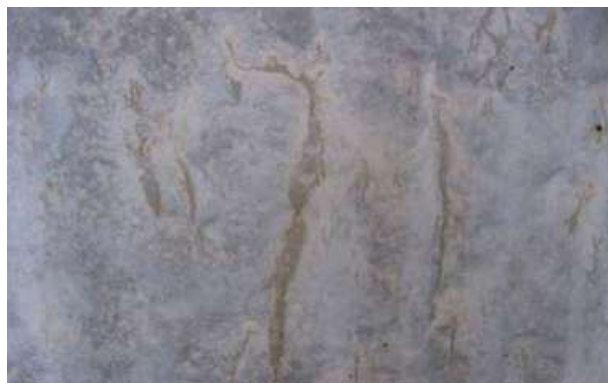
Abb. 10.2.10 Braunverfärbungen durch Trennmittelüberschuss
