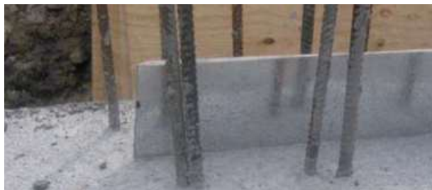
Abb. 8.13.11 Unbeschichtetes Fugenblech
