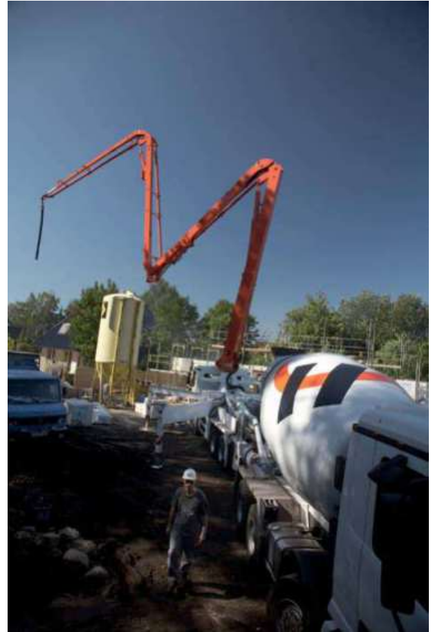
Abb. 4.2.6 Einrichten der Betonpumpe auf der Baustelle
