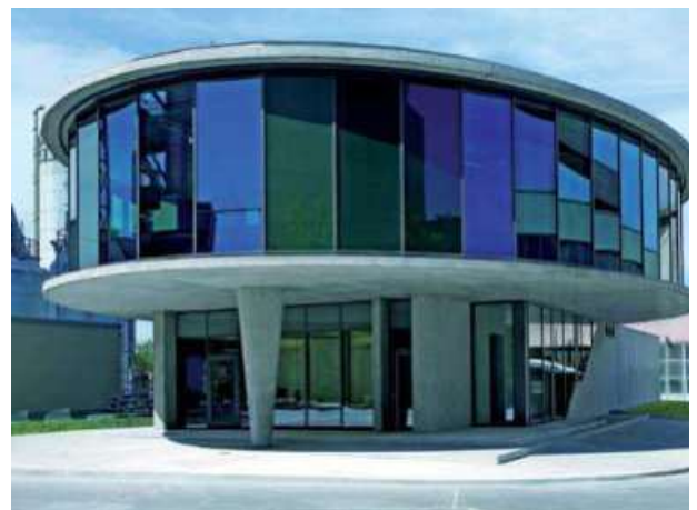
Abb. 8.3.9 Leitstand Holcim (Süddeutschland) GmbH
