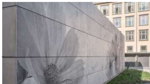
Abb. 9.5.2 Fotobetonfassade Detail Barkhausenbau TU Dresden Bild: solidian GmbH
