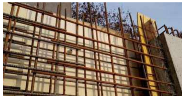
Abb. 8.13.13 Frischbetonverbundfolie bei Ortbeton
