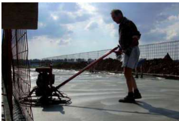
Abb. 8.14.2 Maschinelles Glätten einer Bodenplatte mit dem Flügelglätter - Handglätter
