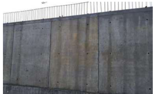
Abb. 10.2.13 Verfärbungen an der Betonoberfläche durch Phenolharz
