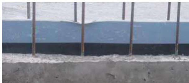
Abb. 8.13.12 Beschichtetes Fugenblech
