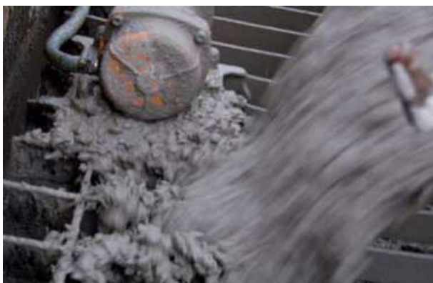
Abb. 7.8.9 Übergabe von Stahlfaserbeton auf die Betonpumpe
