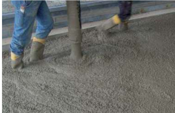
Abb. 7.8.10 Einbringen von Stahlfaserbeton
