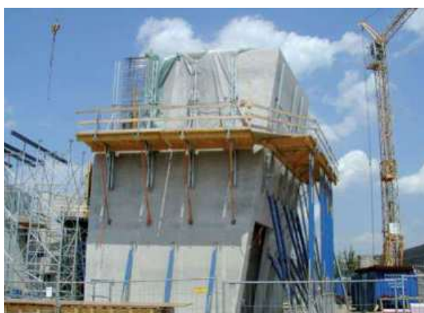
Abb. 7.6.7 Baustelle: Kirche aus Leichtbeton Freiburg - Umkirch
