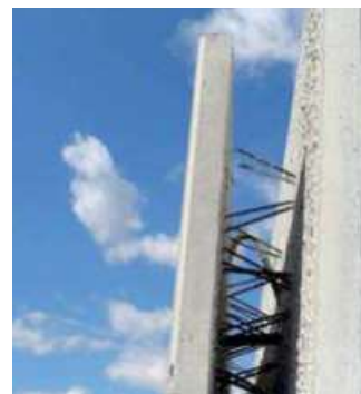
Abb. 7.1.7 Elementwände mit Ortbetonergänzung
