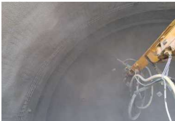
Abb. 8.7.1 Spritzbeton mit dem Spritzmobil aufgebracht
