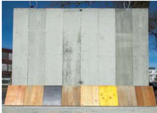
Abb. 8.3.14 Betonoberflächen mit unterschiedlichen Schalungshäuten
