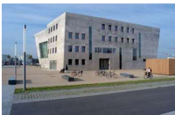
Abb. 7.6.8 Kirche aus Leichtbeton Freiburg - Umkirch
