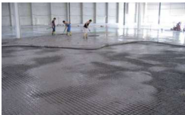
Abb. 8.4.9 Industriebodensystem in zwei Schichten: nass in nass
