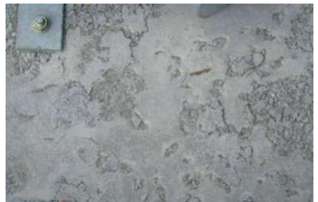
Abb. 10.4.2 Frost-Tausalz-Schaden - Detail
