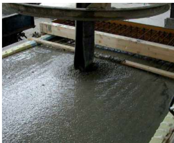
Abb. 7.4.1 Leichtverdichtbarer Beton F6
