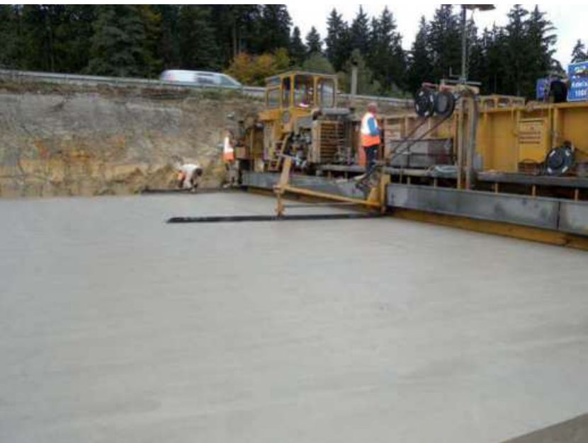
Abb. 8.6.1 Betonstraßenfertiger beim Betoneinbau
