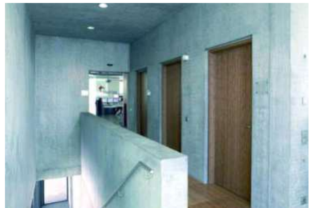
Abb. 8.3.3 Bürotrakt Leitstand Holcim (Süddeutschland) GmbH in Sichtbeton
