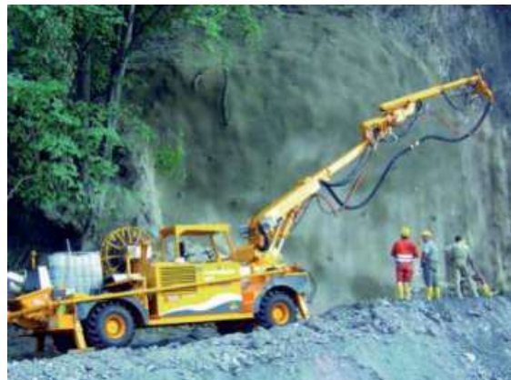
Abb. 7.10.4 Trockenspritzen: Baugrubensicherung
