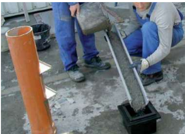
Abb. 7.5.4 Würfelfüllung mit Hilfe einer Rinne zur Entlüftung des Betons
