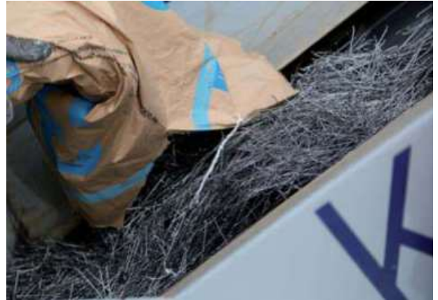
Abb. 8.16.1 Stahlfaserdosierung am Fahrnischer
