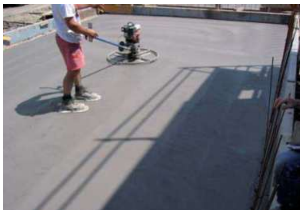
Abb. 8.14.7 Unterschiedliches Abbindeverhalten der Betonoberfläche
