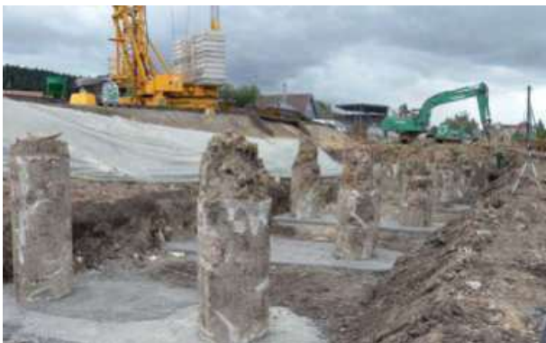
Abb. 8.8.3 (rechts) Erstellen einer Schlitzwand
