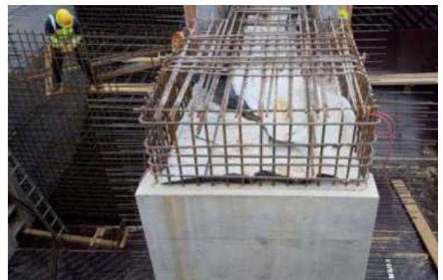
Abb. 8.5.2 Hochwasserschutz am Rhein
