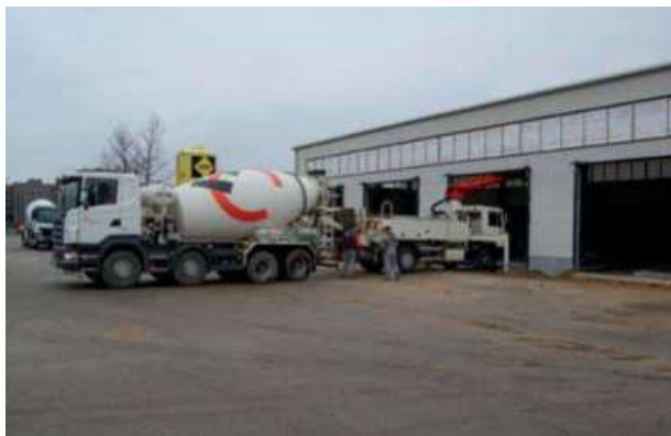
Abb. 7.8.8 Fahrer bei der Übergabe auf die Betonpumpe
