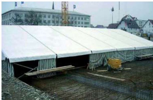
Abb. 5.2.9 Einhausungen bieten einen hohen Schutz vor unerwünschten Witterungseinflüssen
