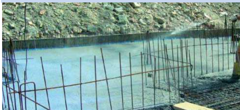
Abb. 5.2.3 Aufsprühen eines Nachbehandlungsmittels
