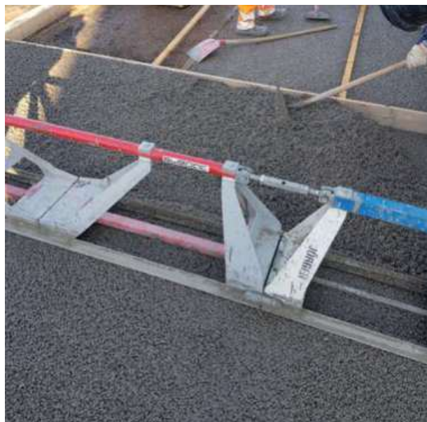
Abb. 7.11.1 Dränbeton beim Einbau, Abziehen mit der Rüttelbohle
