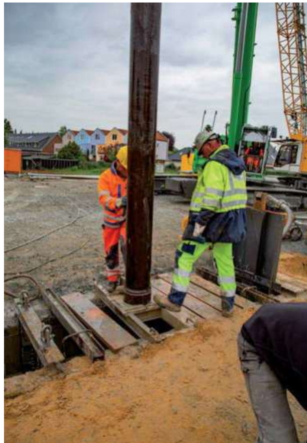
Abb. 8.9.1 (links) Ausheben einer Schlitzwand
