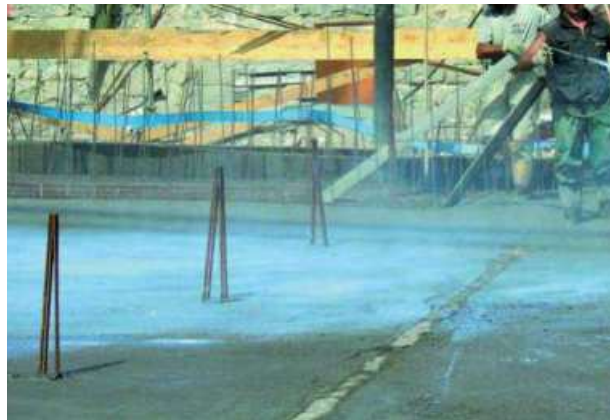
Abb. 5.3.6 Aufsprühen eines Nachbehandlungsmittels unmittelbar nach dem Einbringen
