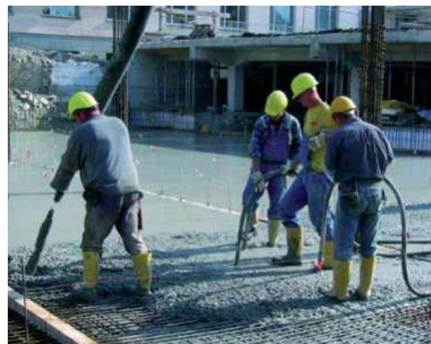
Abb. 7.4.2 Leichtverdichtbarer Beton vereinfacht den Einbau
