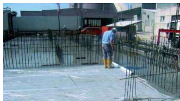
Abb. 5.2.12 Wasserhaltende Nachbehandlung mit Folie
