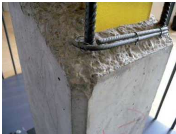
Abb. 3.4.5 Schnitt durch Betonstütze mit Sicht auf Bewehrungseinlage
