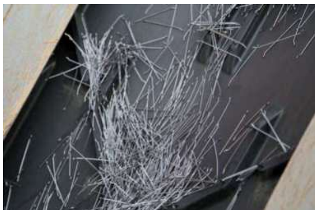
Abb. 1.7.8 Dosieren von Stahlfasern
