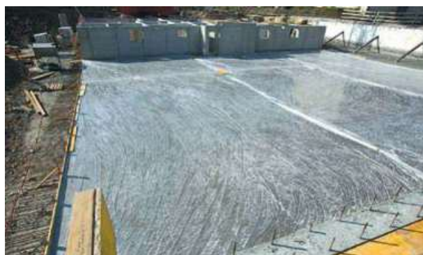
Abb. 5.2.1 Abdecken einer Betonplatte mit Folie
