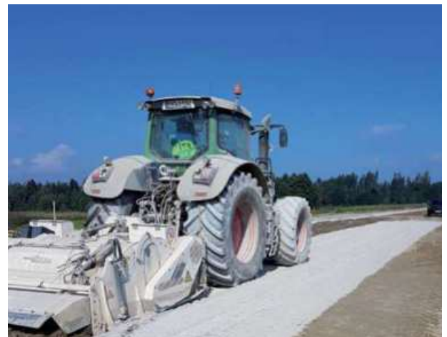
Abb. 8.18.3 Maschine beim Ausstreuen von Bodenverfestigungsmaterial
