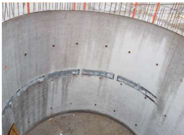
Abb. 1.4.6 Sichtbeton Treppenhaus aus R-Beton mit Gesteinskörnung Typ 2
