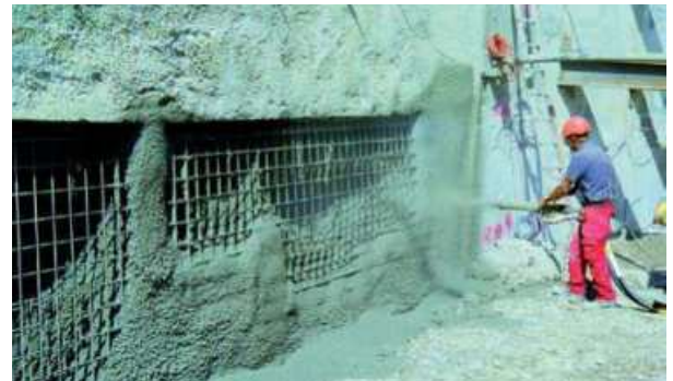
Abb. 7.10.7 Sicherung einer Baugrube mit Spritzbeton
