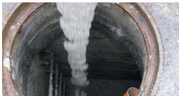
Abb. 7.6.15 Hohlraumverfüllung mit Porenleichtbeton
