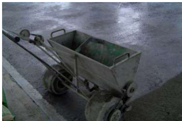
Abb. 8.14.5 Hartkornstreuung mit dem Streuwagen
