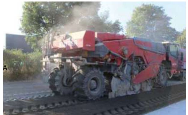
Abb. 8.18.2 Maschine beim Ausstreuen von Bodenverfestigungsmaterial
