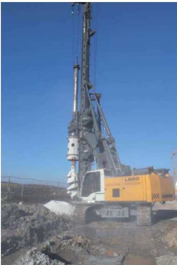
Abb. 8.8.10 (rechts u.) Große Baustelle bei der Erstellung von Bohrpfählen
