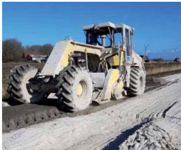
Abb. 8.18.10 (links) Übergabe von Bodenverbesserungsmaterial
