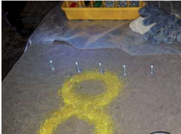
Abb. 7.10.13 (links) Messung der Frühfestigkeit mit der Penetrationsnadel nach wenigen Minuten
