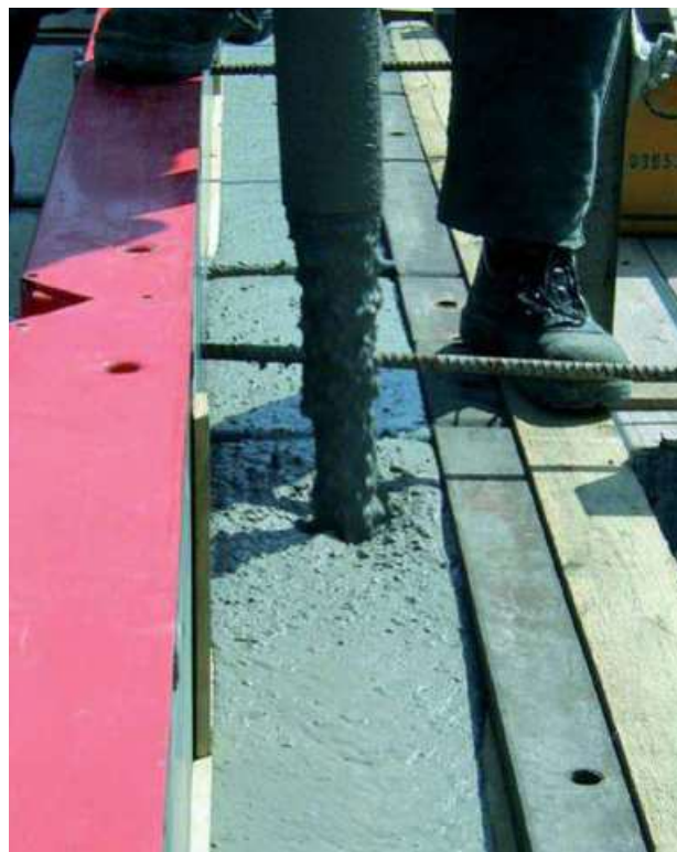
Abb. 7.5.13 Eine Person genügt, um eine Wand mit SVB zu betonieren
