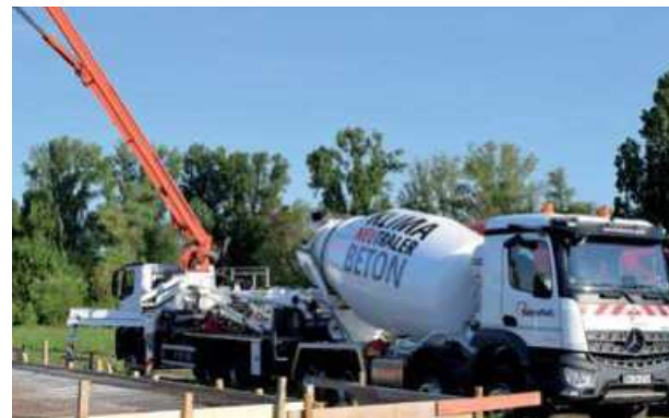
Abb. 3.5.2 Klimaneutraler Beton "EcoPactZero" beim Betoneinbau
