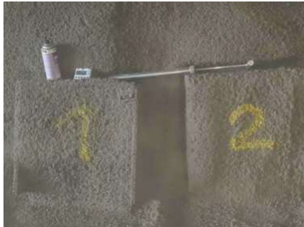
Abb. 7.10.11 (links) Herstellen einer Spritzkiste zur Messung der Festigkeitsentwicklung
