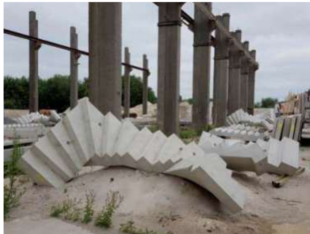
Abb. 9.1.1 Betonfertigteile (Treppen) auf dem Lagerplatz
