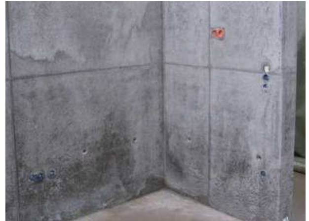
Abb. 8.3.6 Herstellung von Sichtbeton bei ungünstigen Umweltbedingungen (kalt, nass)
