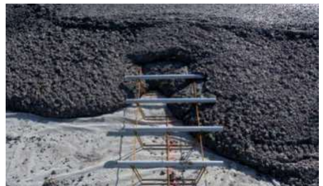
Abb. 8.4.19 Verdübelung durch Dübeleinkorb beim Betonieren
