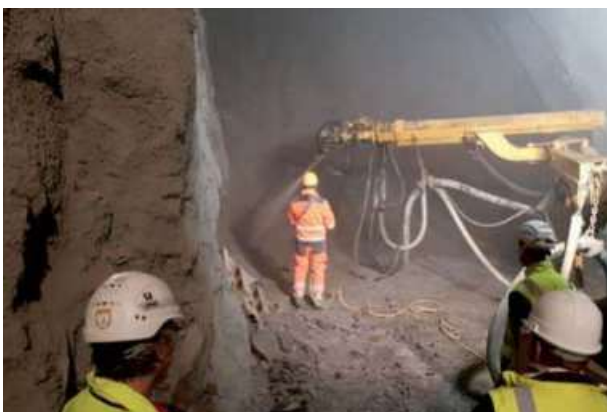
Abb. 7.10.9 (rechts) Aufbringen von Spritzbeton mit einem Spritzbetonroboter am Tunnelportal
