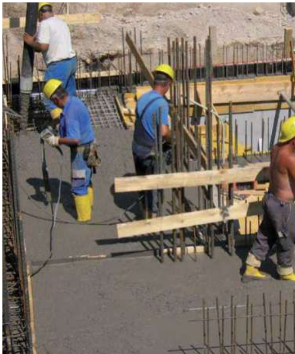
Abb. 7.4.5 Leichtverdichtbarer Beton F6
