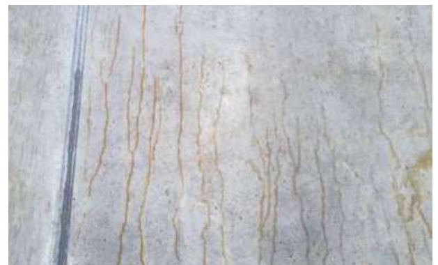
Abb. 10.2.13 Verfärbungen an der Betonoberfläche durch Phenolharz
