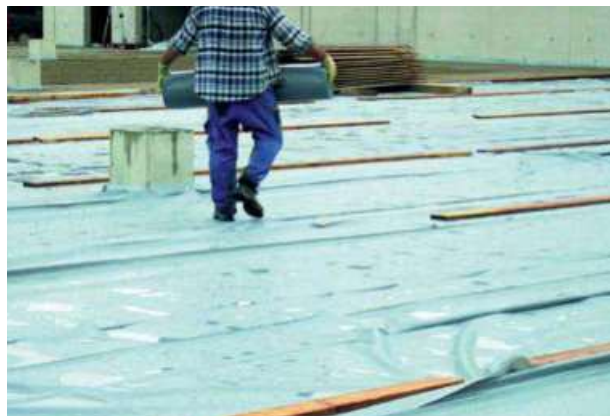
Abb. 5.3.7 Abdecken mit Kunststofffolien und sichern durch Bretter
