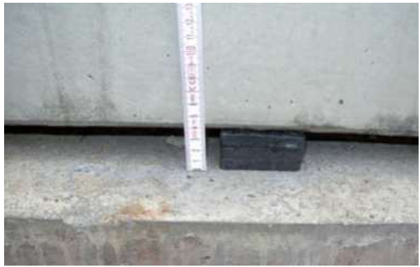
Abb. 7.1.10 (links) Aufständern von Elementwänden
