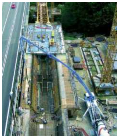
Abb. 8.15.2 (rechts) Winterbetonage mit einer stationären Betonpumpe
