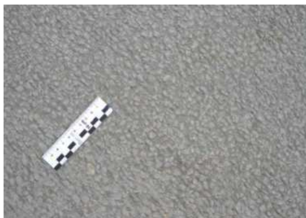
Abb. 8.6.4 (links) Autobahn aus Beton - Oberfläche mit Besen abgetragen
