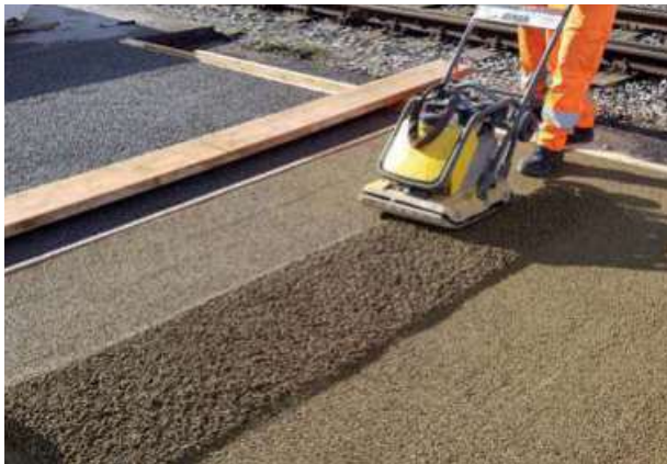
Abb. 7.11.5 Holcim CampoDrain Handeinbau und Verdichtung
