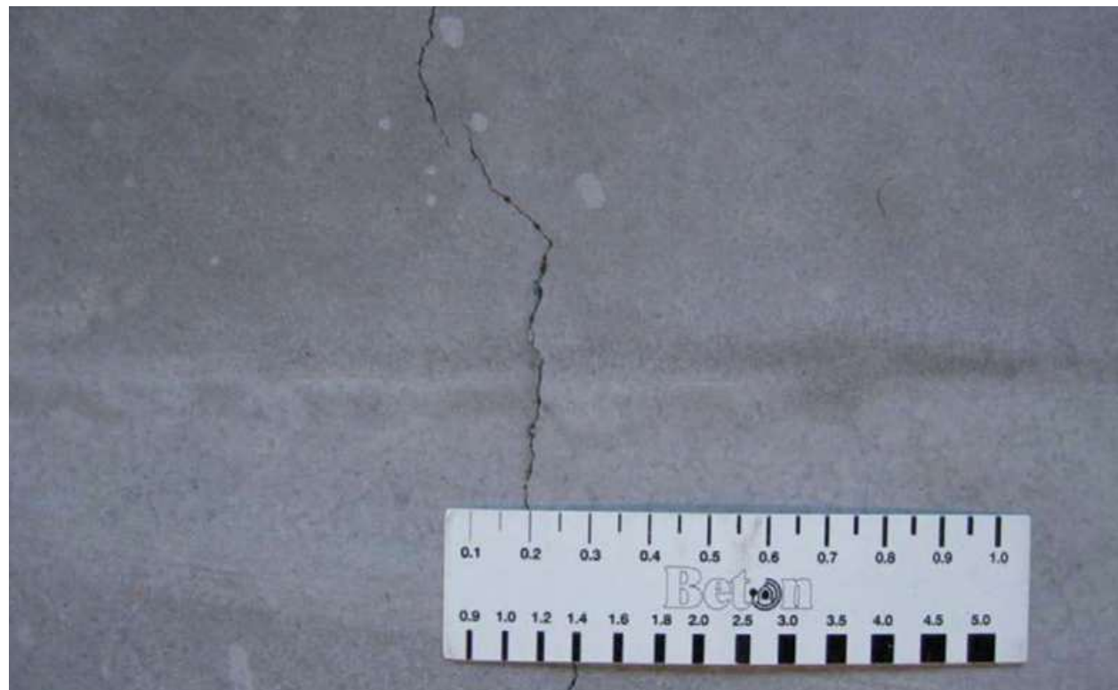
Abb. 10.3.6 Risse infolge Trocknungsschwinden
