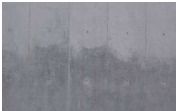
Abb. 10.2.17 Dunkelfärbung der unteren Schüttlage
