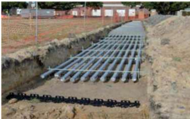
Abb. 7.17.2 (links) Wärmeleitfähiger Beton zur Verfüllung von Rohrlei-tungsgräben
