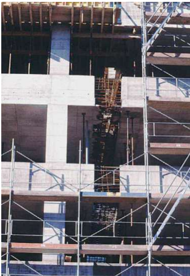
Abb. 10.3.2 Schwindgasse bei einem großen Gebäude
