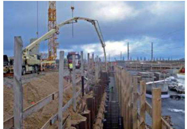
Abb. 8.17.3 Einsatz einer Pumpe bei großvolumiger Bauwerkshinterfüllung
