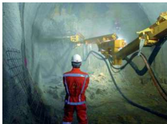
Abb. 7.10.5 Felssicherung mit Spritzbeton direkt beim Abbau
