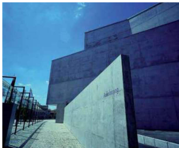
Abb. 8.3.5 Sichtbeton Stadthalle Tuttingen
