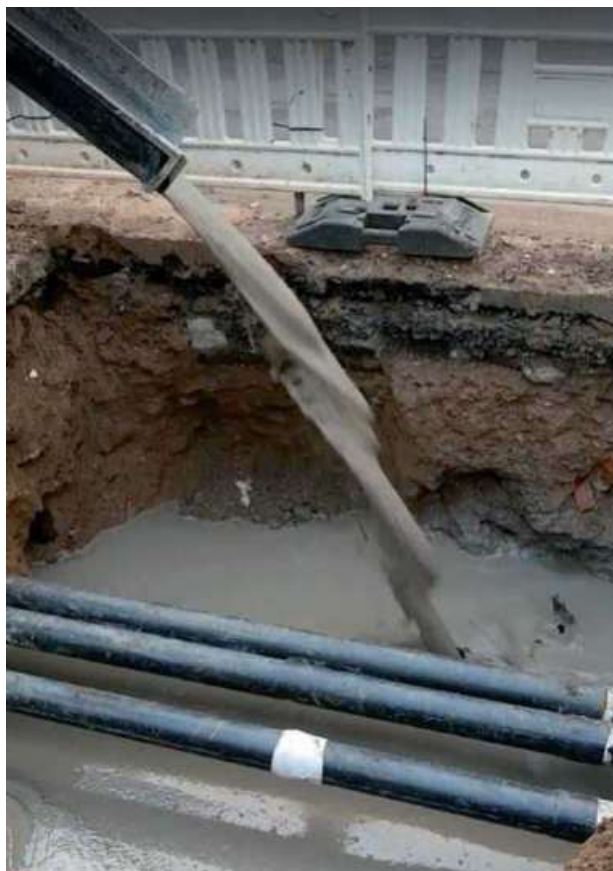
Abb. 7.17.6 Verfüllung direkt aus dem Fahrmischer
