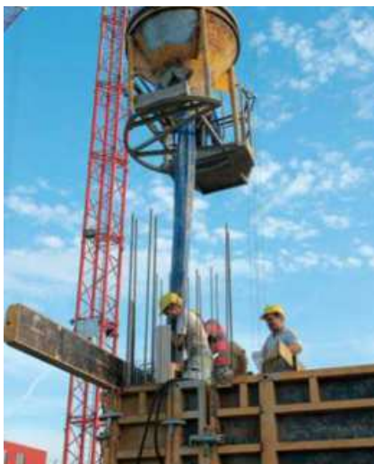
Abb. 8.13.14 Betonierkübel mit Schlauch
