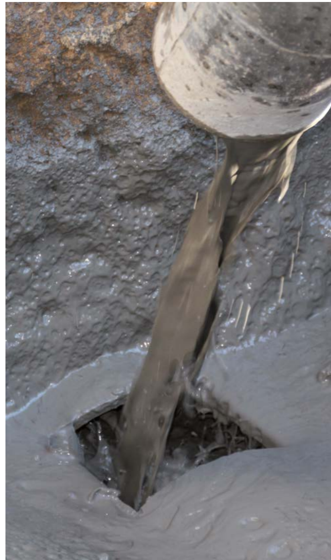
Verfüllung stillgelegte Rohrleitung
