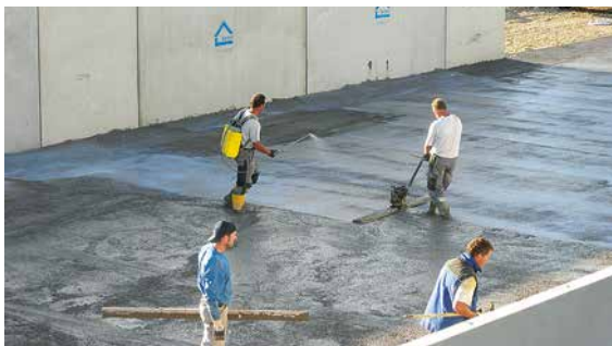
Abb. 4.1 Betoneinbau und Verdichtung
