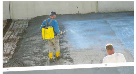
Abb. 4.2 Zwischennachbehandlung mit Curing
