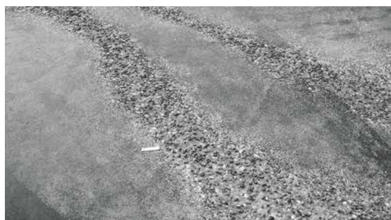
Abb. 10.2 Schäden im Gärsäureblauf
