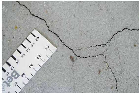
Abb. 13.2 Gerissene Betonoberfläche
