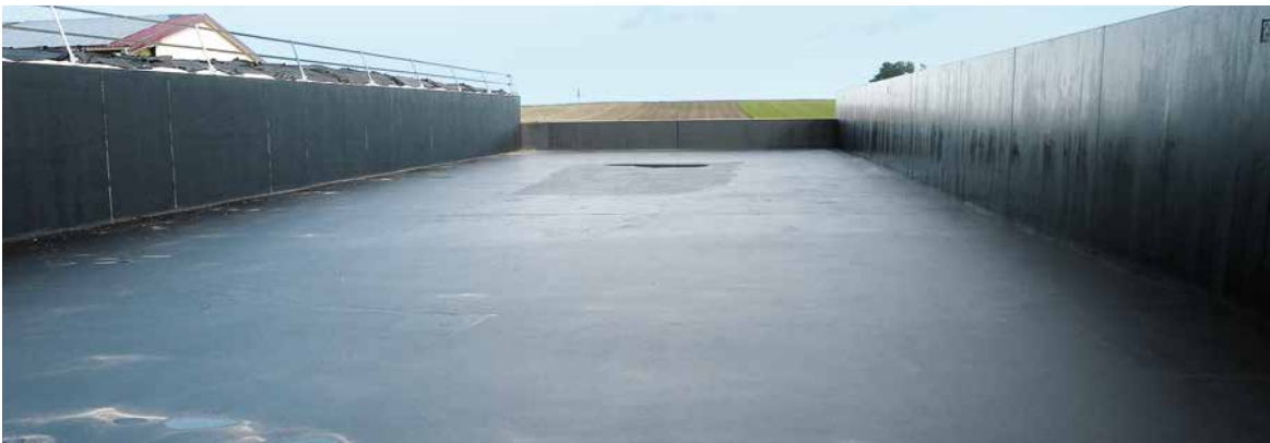
Abb. 7.1 Schutzanstrich mit Silolack
