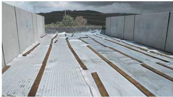
Abb. 6.2 Nachbehandlung mit Folie und Thermomatten
