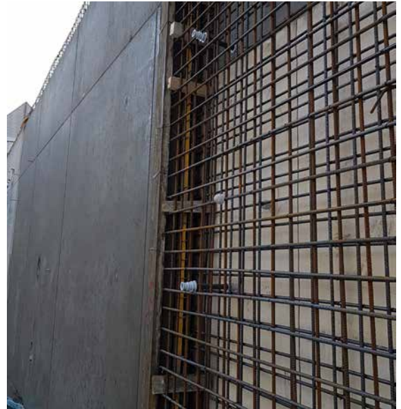
Abb. 12.8 Ausnutzung der Mindestwandstärke
