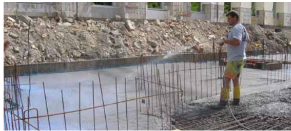
Abb. 10.1 Aufsprühen von geeigneten Curingmitteln
