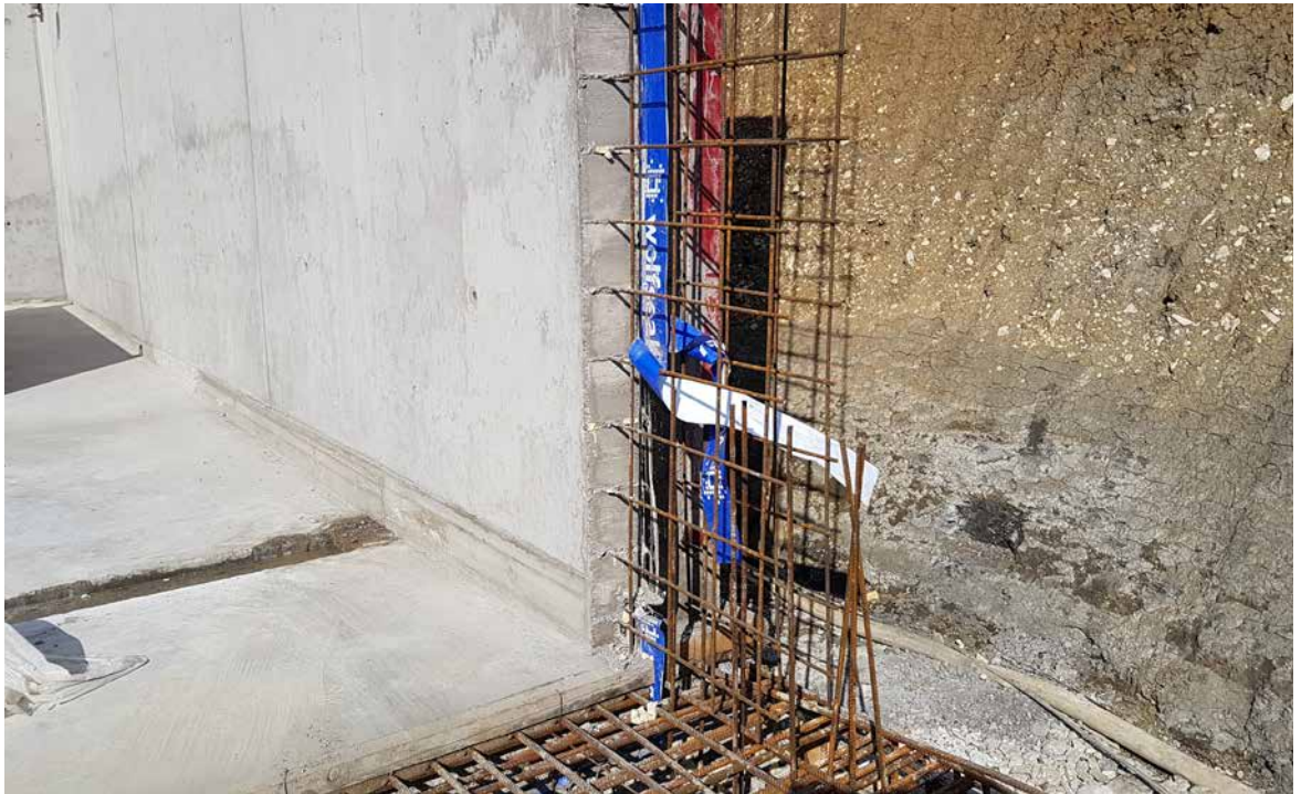
Abb. 4.4 Ausführung von Arbeitsfugen
