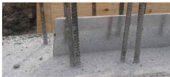
Abb. 11.2 Unbeschichtetes Fugenblech
