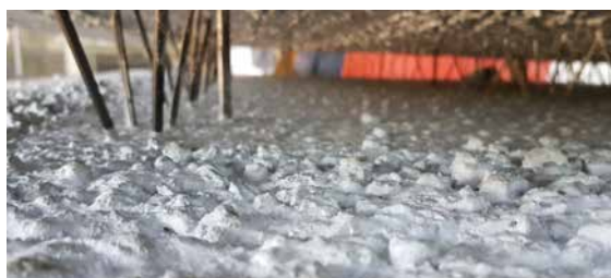
Abb. 13.6 Rautiefe einer Elementwand
