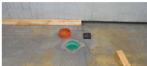
Abb. 12.7 Betonaustritt durch Abschalen verhindern
