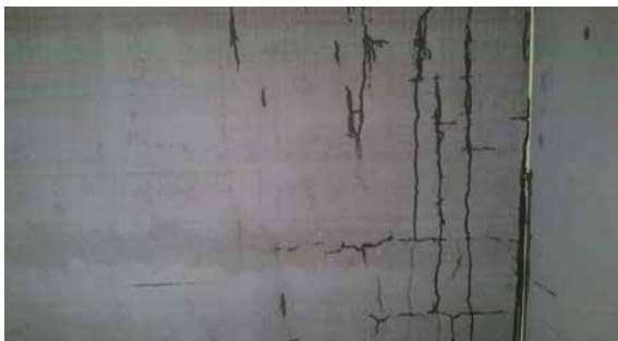
Abb. 3.1 Wasserführende Risse
