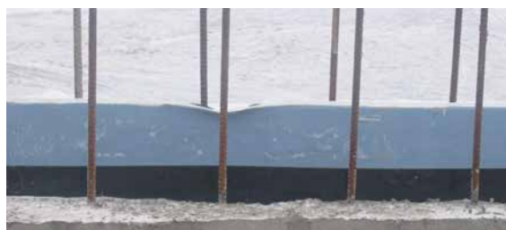
Abb. 11.3 Beschichtetes Fugenblech
