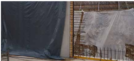
Abb. 10.6 Dampfdichte Folien – Wände
