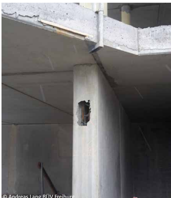
Abb. 13.19 Tragende Wand ohne vollständige Verfüllung
