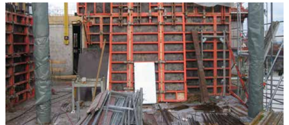
Abb. 10.7 Belassen in der Schalung
