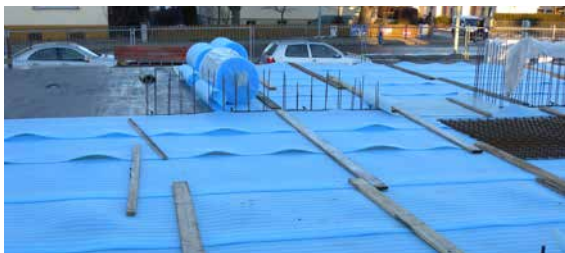
Abb. 10.4 Abdecken mit Wärmedämmmatten
