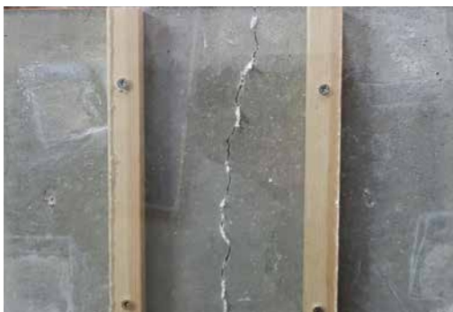
Abb. 8.4 Rissflanke mit Kristallbildung
