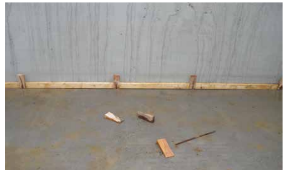
Abb. 13.12 Abschalen der Sohlfuge
