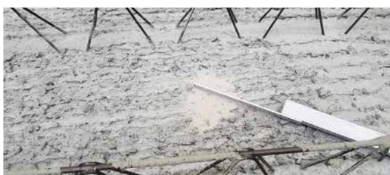
Abb. 13.7 Prüfung der Rautiefe mit dem Sandflächenverfahren
