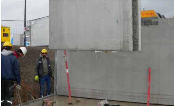
Abb. 13.9 Versetzen der Kellerwände
