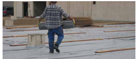
Abb. 10.9 Dampfdichte Folien – Bodenplatte
