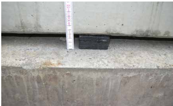
Abb. 13.11 Aufständern der Elementwände
