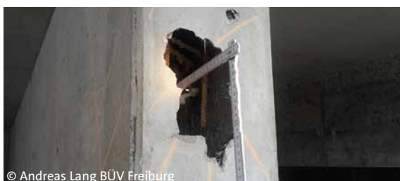
Abb. 13.18 Sehr große Hohlstelle in der Elementwand
