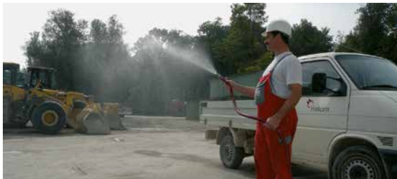
Abb. 10.2 Besprühen mit Wassernebel
