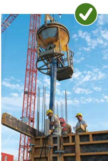
Abb. 12.1 Betonierkübel mit Schlauch
