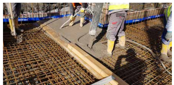
Abb. 12.11 Betoneinbau
