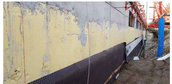
Abb. 11.5 Frischbetonverbundfolie bei Ortbeton
