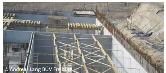
Abb. 13.15 Elementwände mit sehr schlankem Kernbeton
