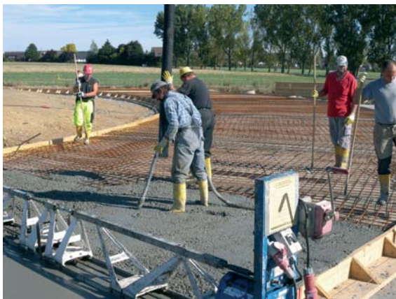
Verdichten des Betons mit Rüttelflasche
