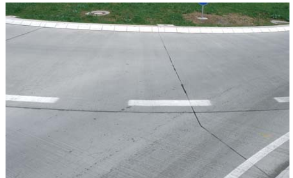
Plattenbauweise mit Schein- und Pressfugen
