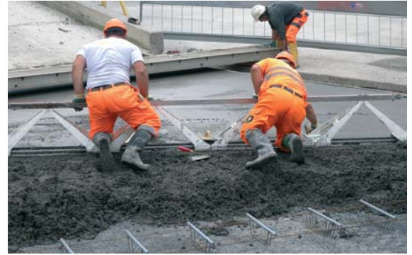
Steifplastischer Beton – optimale Betonkonsistenz für den Handeinbau
