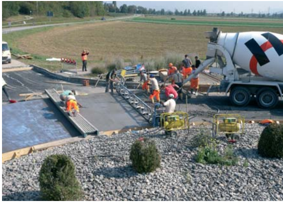
Bei unbewehrten Platten kann der Fahrmischer direkt bis zum Einbauort fahren
