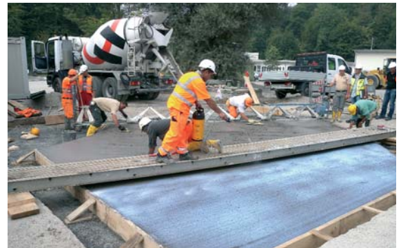
Aufsprühen eines Nachbehandlungsmittels auf die Erprobungsfläche im Werk Haltingen
