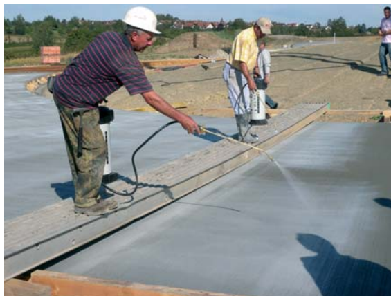
Aufsprühen von Curing-Compound als Verdunstungsschutz
