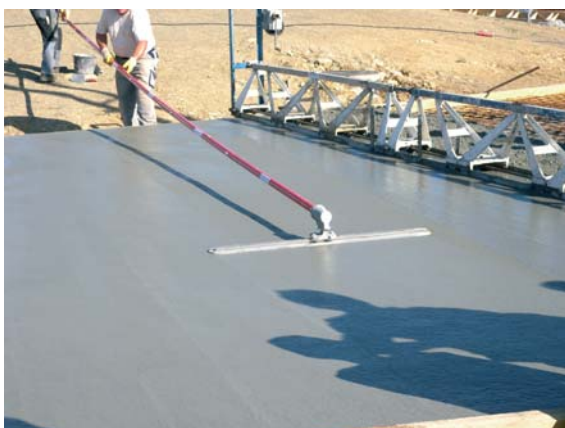
Verbesserung der Ebenheit mit Glättebohle
