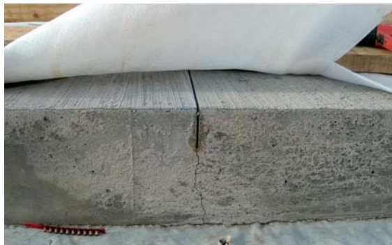
Der Fugenschnitt reicht bis auf einen Drittel der Plattendicke und sorgt für ein kontrolliertes Reißen
