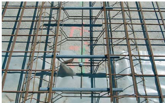
Über diesen (blauen) Dübeln wird später der Fugenschnitt erfolgen
