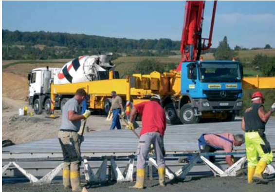
Betoneinbau mit Pumpe direkt aus dem Fahrmischer
