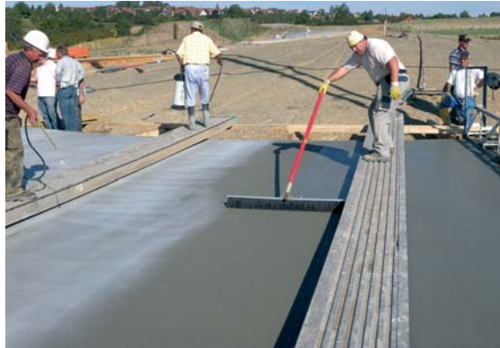
Der Besenstrich macht die Fahrbahn griffiger
