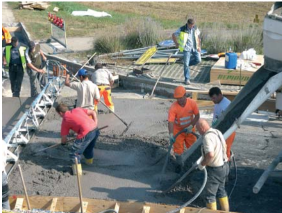
Einbringen und Verdichten des Betons
