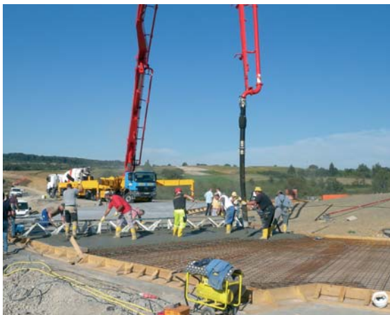
Betoneinbau mit Pumpe
