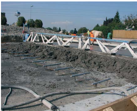
Unbewehrte Ausführung mit Dübeln auf sauber gestellten Stützkörben
