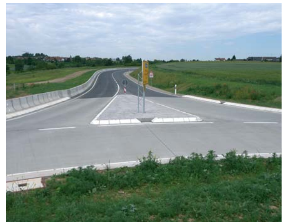
Der Einfahrtsbereich ist vom Kreisverkehr konstruktiv getrennt
