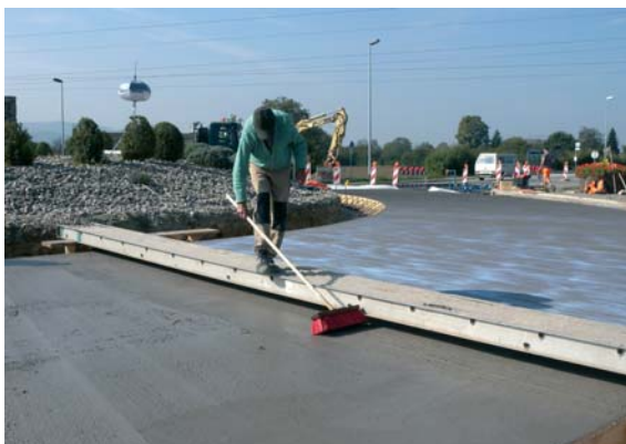
Aufbringen des Besenstrichs
