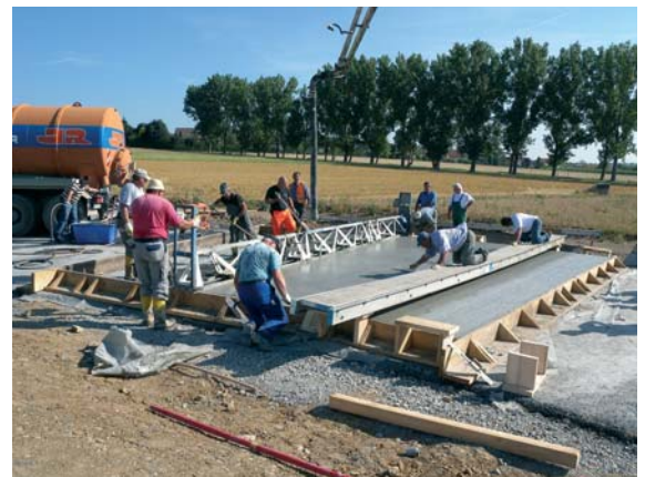
Einbau des Betons im Testfeld
