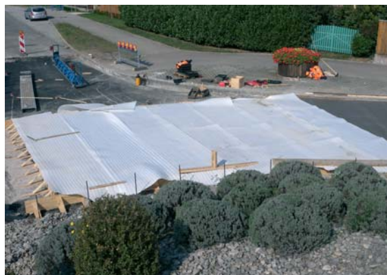
Optimale Nachbehandlung mit Wärmedämmmatten
