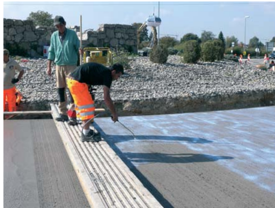
Aufsprühen des Curing-Compounds
