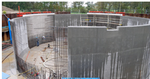
Bild 6: Kläranlage – Massiges Bauteil
