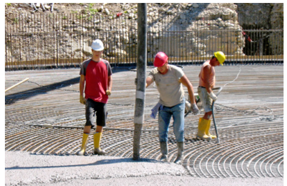
Bild 13: Betoneinbau
