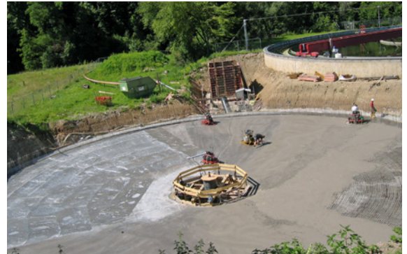
Bild 12: Bodenplatte Kläranlage
