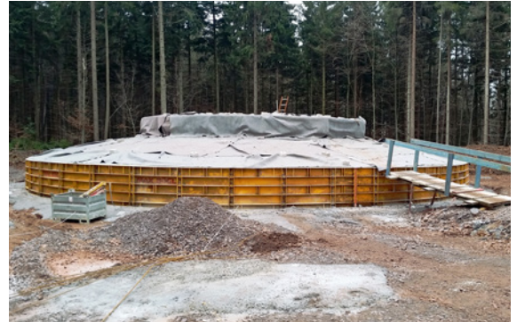
Bild 16: Fundament Windkraftanlage
