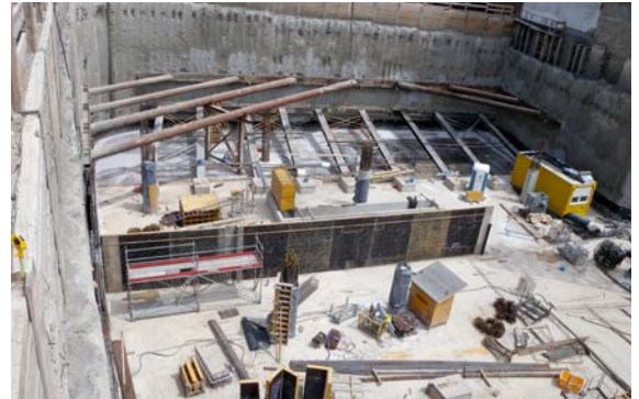
Bild 12: Bodenplatte Gerberareal
