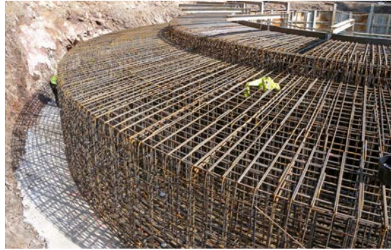
Bild 18: Fundament Windkraftanlage
