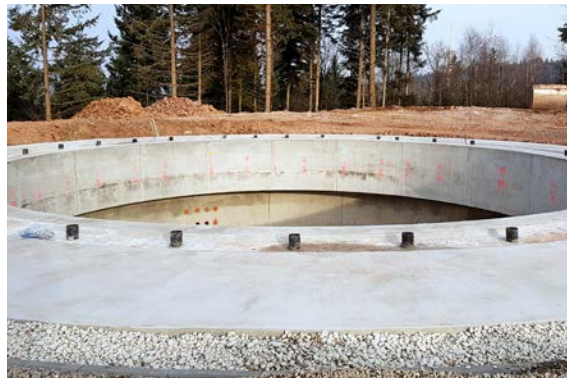
Bild 27: Fundament Windkraftanlage
