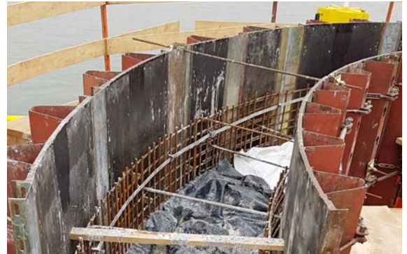
Bild 24: Wand Einlassbauwerk Rhein
