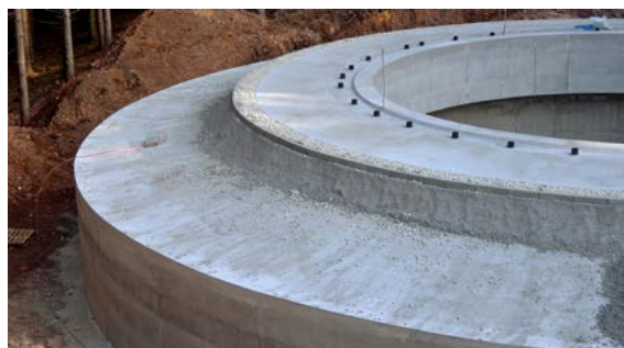
Bild 7: Massiges Fundament
