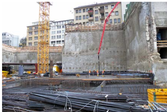
Bild 11: Massige Bodenplatte
