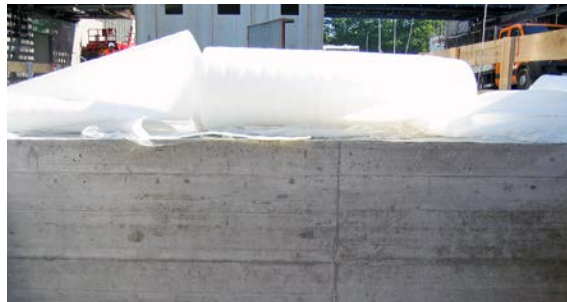
Bild 6: Massige Bodenplatte
