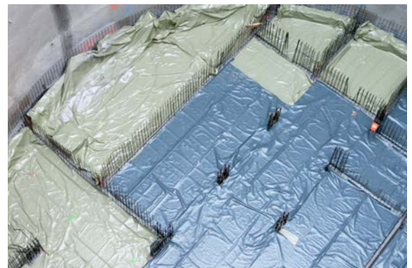
Bild 21: Nachbehandlung Bodenplatte
