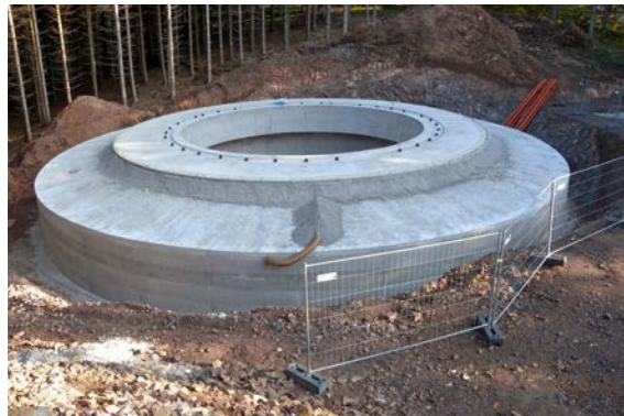
Bild 19: Fundament Windkraftanlage
