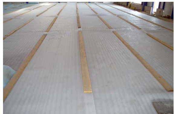
Bild 9: Nachbehandlung mit Thermomatten
