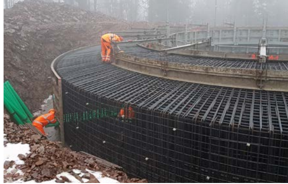
Bild 26: Fundament Windkraftanlage
