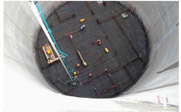
Bild 20: Betonage Bodenplatte
