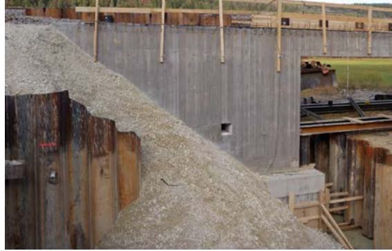
Bild 14: Brückenwiderlager
