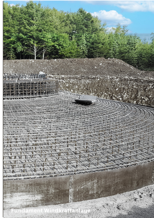
Massige Bodenplatte
