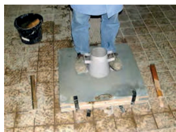
Trichter durch aufstellen der Füße gegen aufschwimmen sichern
